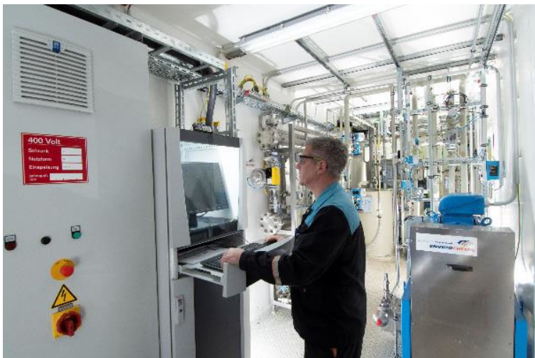
Bild: Im Verbundprojekt ReSalt entfernt die vollautomatisierte Hochdruckosiose-Anlage von EnviroChemie Kochsalz aus Industrierwasser und konzentriert es auf. ©Bild Covestro
