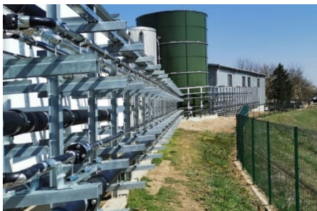
Photo : Les eaux usées du traitement des fruits sont nettoyées pour garantir les valeurs seuil requises.
