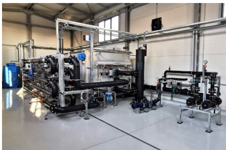
Photo : Une installation de flottation Flomar est le principal composant du traitement des eaux usées.
