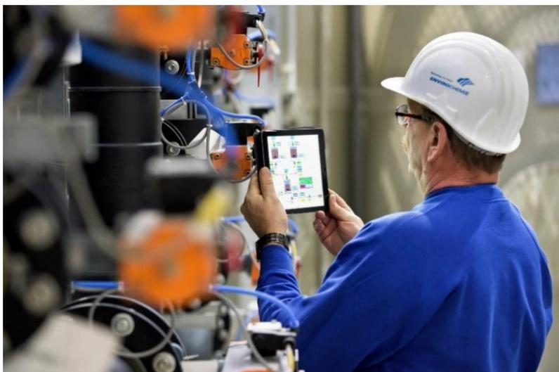
Je nach Abwasserart erzielen unterschiedliche Chemikalien, Dosiermengen und Reaktionszeiten ein besseres Reinigungsergebnis - hier setzt der „digitale Zwilling“ an. Dieser erhält Informationen aus der Produktion über das derzeit anfallende Abwasser, simuliert verschiedene Szenarien der Abwasserbehandlung und wählt so die geeigneten Chemikalien, Dosiermengen und Reaktionszeiten.
