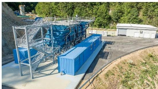
Bilder: Modulare Behandlungsanlage für Minenabwasser von Ellatzite-Med in Bulgarien.
