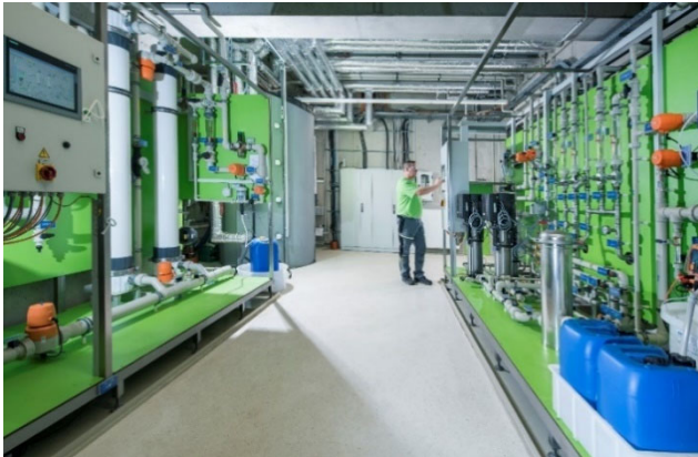
Bild: Zentrale EnviroFALK Wasseraufbereitung gemäß DIN EN ISO 15883 für die Sonderisolierstation in einem Krankenhaus.
