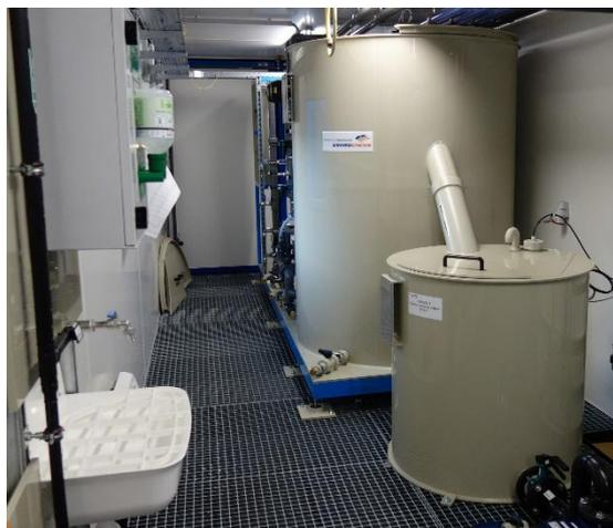
Image : Aperçu du local technique EnviModul avec l'installation de flottation Lugan® 10 000 pour le traitement des eaux usées.
