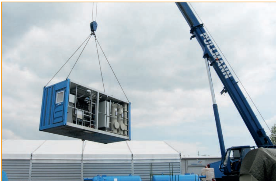
Einfaches Umsetzen einer EnviModul-Anlage für die Abwasserbehandlung in der chemischen Industrie.
