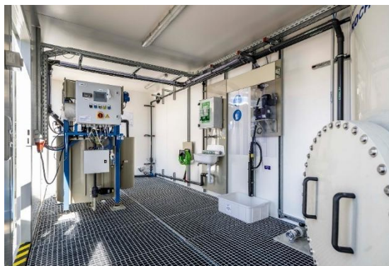
Bild: Blick in die EnviModul Abwasserbehandlung mit Split-O-Mat SOM 500LB Chargenanlage.
