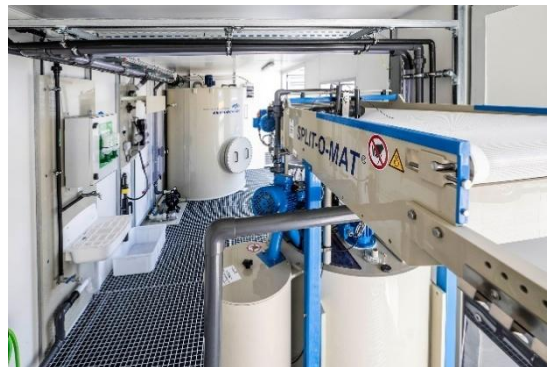
Bild: Blick in die EnviModul Abwasserbehandlung mit Split-O-Mat SOM 500LB Chargenanlage.
