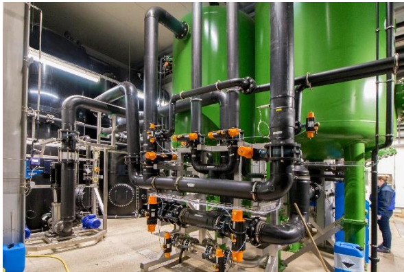
Bild: Brüdenwasseraufbereitung – Mehrschichtfilter
