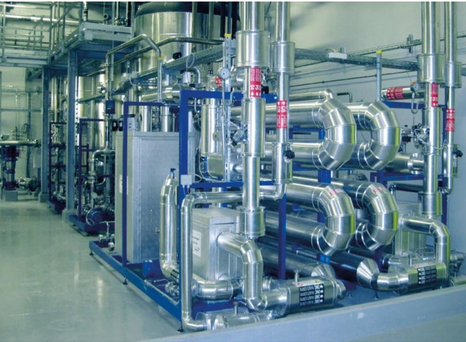
SteriFix-Anlagen sind dafür konzipiert, Abwässer mit infektiösen oder genetisch veränderten Stoffen durch thermische Sterilisation sicher zu inaktivieren, zu sterilisieren und zu desinfizieren. Gleichzeitig werden bei diesem Vorgang Mikroorganismen und Bakterien beseitigt, wobei auch Viren, Plasmide und DNA-Fragmente deaktiviert werden können. Zusätzlich sorgt das SteriFix-Verfahren für ein optimales Sterilisationsergebnis bei effizientestem Energieeinsatz.
