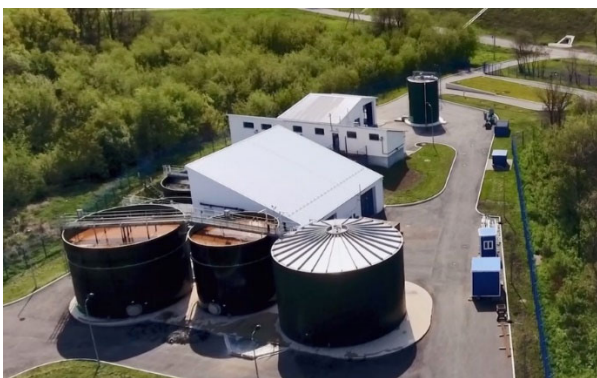
Biomar® biologische Abwasserbehandlung für die Käserei Hochland
