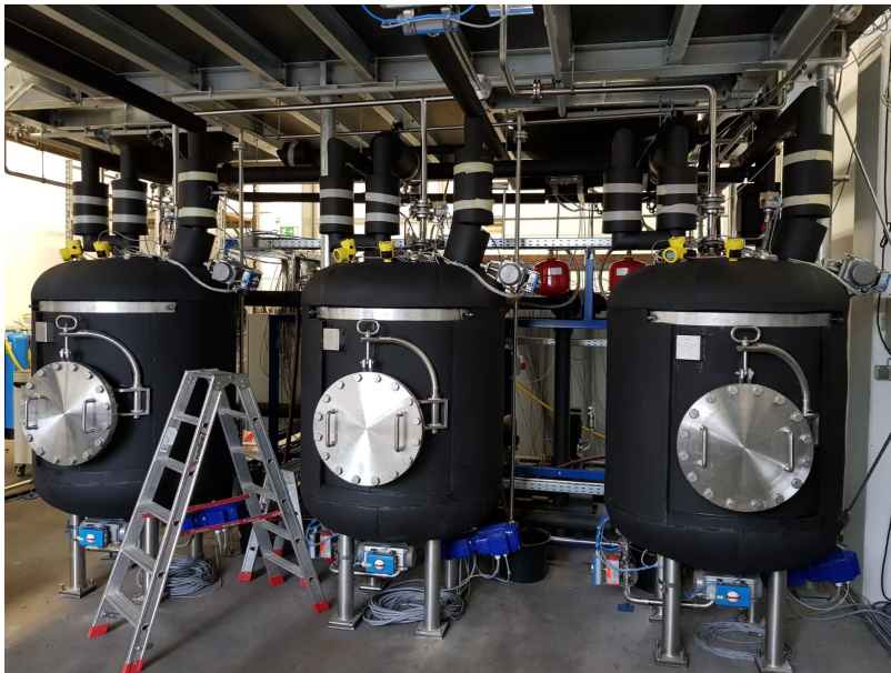
Bild: Während der Installation der Sterifix Abwasserdesinfektionsanlage beim RIVM in Utrecht.
