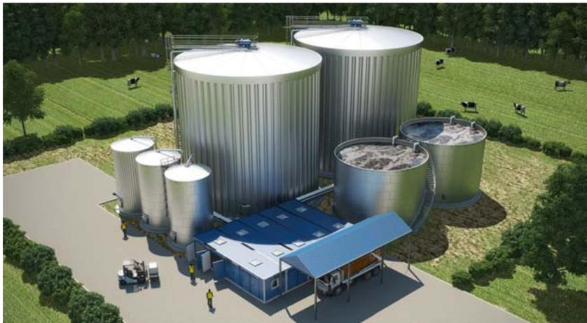
Bild: Mit einer mehrstufigen, biologischen Behandlungsanlage für hochbelastete Abwasserströme und flüssige Abfälle erzeugt eine Großmolkerei Biogas.
