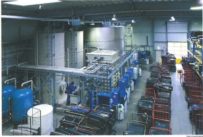
gesammelt und zentral als Mischabwasser behandelt werden. Die gezielte Behandlung hochkonzentrierter Industrieabwasserströme ermöglicht nicht nur die Rückführung von Wasser; teilweise lassen sich auch Sekundärprodukte aus dem Abwasser gewinnen.
