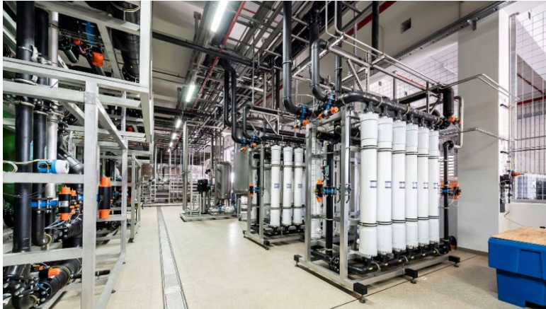
Bild: Mit einer Recyclinganlage für Brüdenkondensate spart eine Molkerei Frischwasser und entlastet seine Abwasserbehandlungsanlage.
