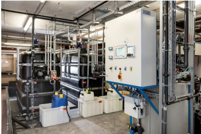
Kompakte Split-O-Mat® SOM 500 Abwasserbehandlungsanlage
